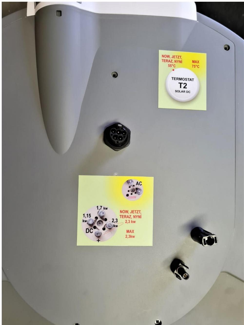
**Obr.č.4** Plastový kryt elektroinštalácie umiestnený na spodnej časti zásobníka vody
